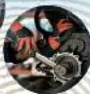
Instalación de equipos industriales
